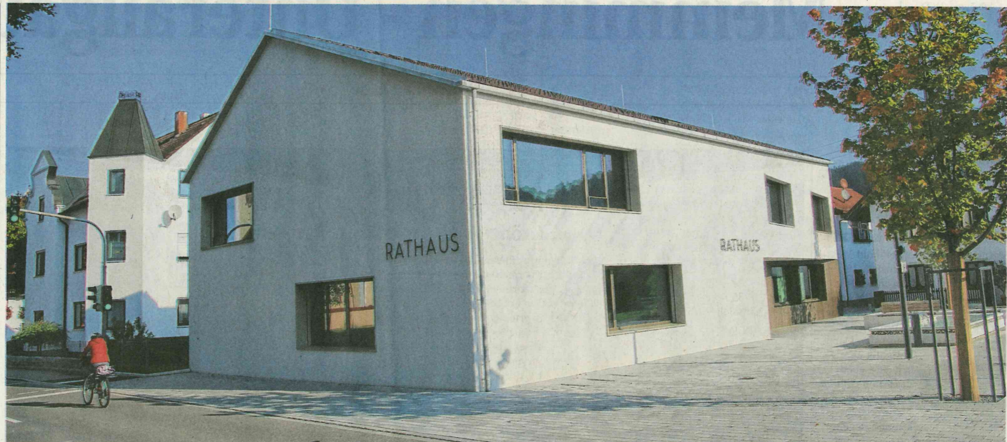
Der Bau des neuen Rathauses hat rund eineinhalb Jahre gedauert.
