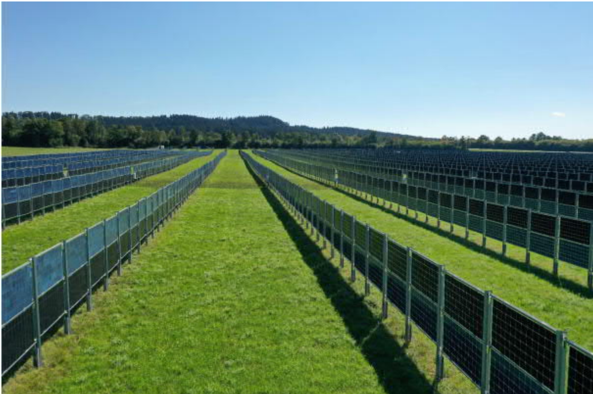
Foto einer vertikal aufgeständerten Agri-PV-Anlage in Donaueschingen-Aasen (Johannes Scharf, TFZ, 09.09.2020)
